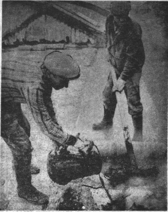
Каменщики стройучастка Лодейнинского СМУ — мастера на все руки. Каждый из них владеет несколькими строительными специальностями. Как и весь коллектив строительно-монтажного управления, каменщики взяли повышенные обязательства по достижению XXVI съезда КПСС и успешно его выполняют. Они решили в совершенстве овладеть специальностями кровельщиков. Сейчас они заканчивают настелить мягкую кровлю на крыше Терберских судоремонтных мастерских. Качество работ здесь высокое, ведь руководит работами коммунист Василий Петрович Маев.
