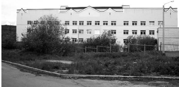
Реконструкция акушерского отделения ЦРБ закончилась в 2006 году. Роддом стал еще на этаж выше.
