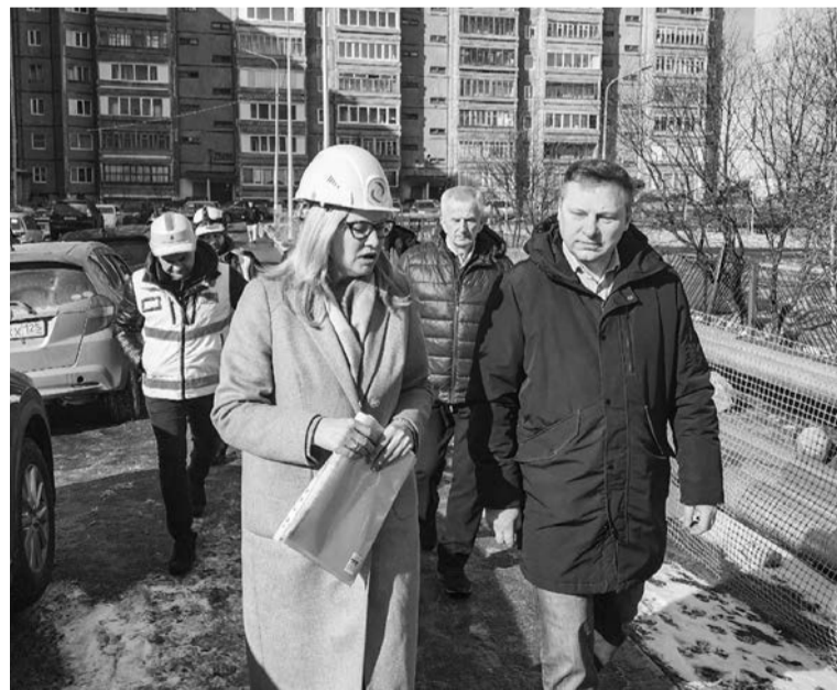
Алла Истомина и Олег Прасов детально обговорили все этапы производства ремонтных работ на ул. Полярной.
