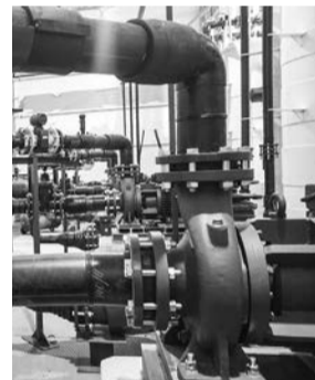
Новая станция будет выдавать 12 тысяч куб. метров воды в сутки.
