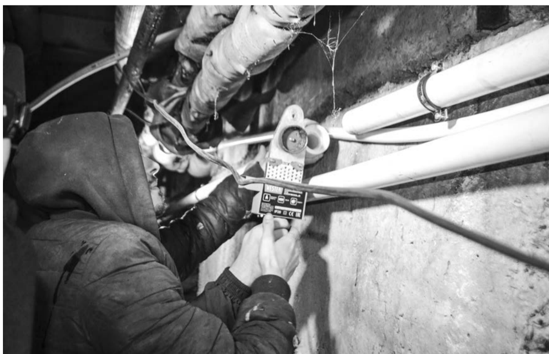
В подвале дома 34а на ул. Гвардейская произведена замена протекающих железных труб на полипропиленовые, что должно решить проблему давления при подаче холодной воды.
