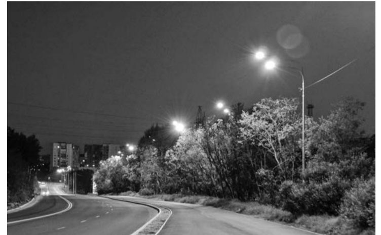
Благодаря комплексному подходу на ул. Пикуля полностью заменено асфальтобетонное покрытие проезжей части и тротуара, установлены новые светильники, вскоре появятся лавочки и урны.
