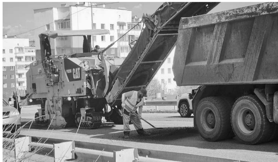
Первый этап — снятие старого покрытия. Работы проводит ООО «Северная Транспортная Компания».
