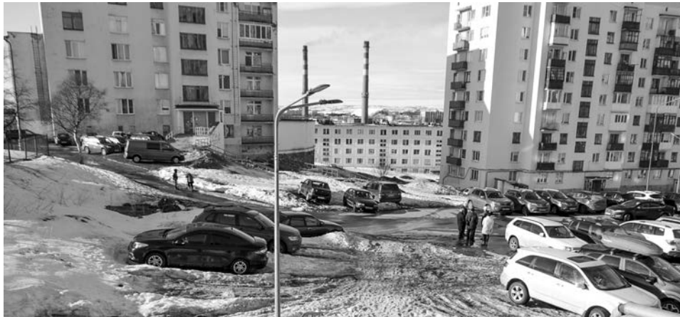
Во время ремонтных работ на ул. Морской по возможности будет расширена проезжая часть и увеличено количество парковочных мест.
