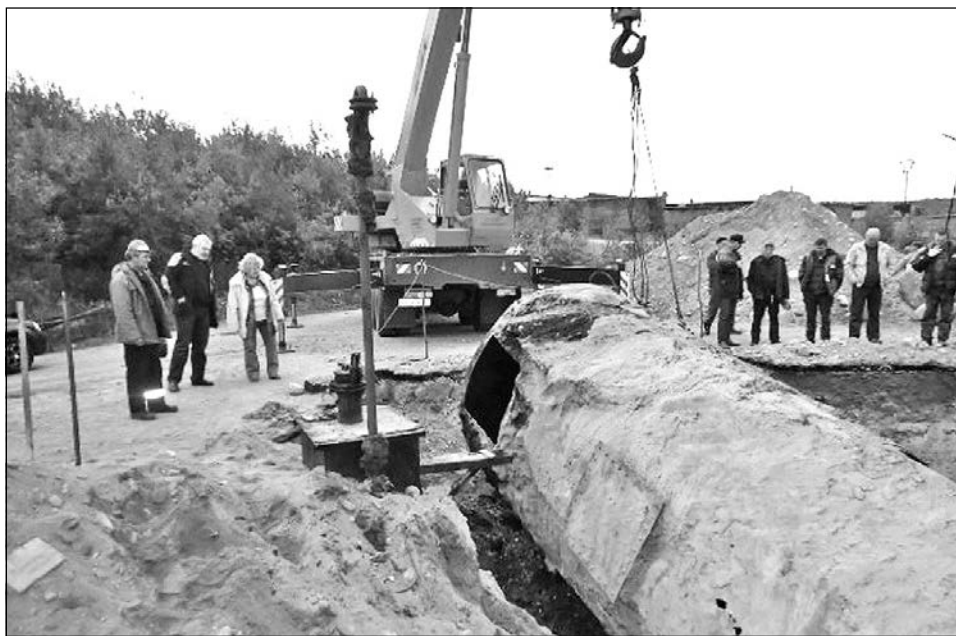
Замена мазутоприемной емкости на 33 ТЦ на ул.Комсомольской.
