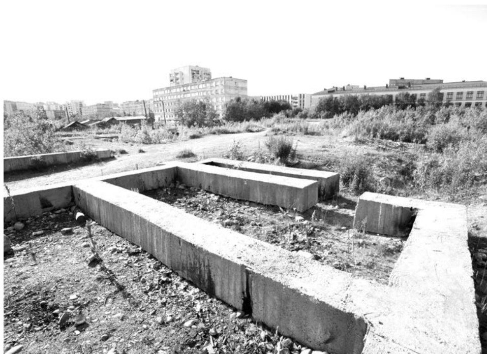
В 90-х годах на ул.Кирова был заложен фундамент под дополнительный корпус школы №1, но стройку заморозили. Скоро здесь снова закипит работа - начнется возведение трехэтажного детского сада на 220 мест.
