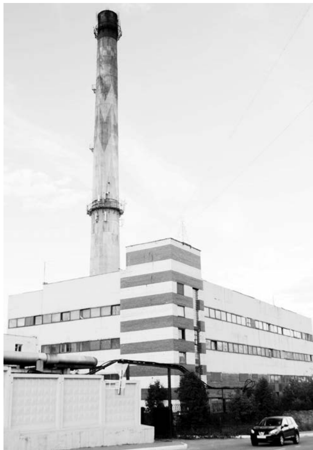
Ремонт сетей и оборудования североморских котельных призван не допустить повторения истории прошлого отопительного сезона, принесшего более 230 отключений тепла.
