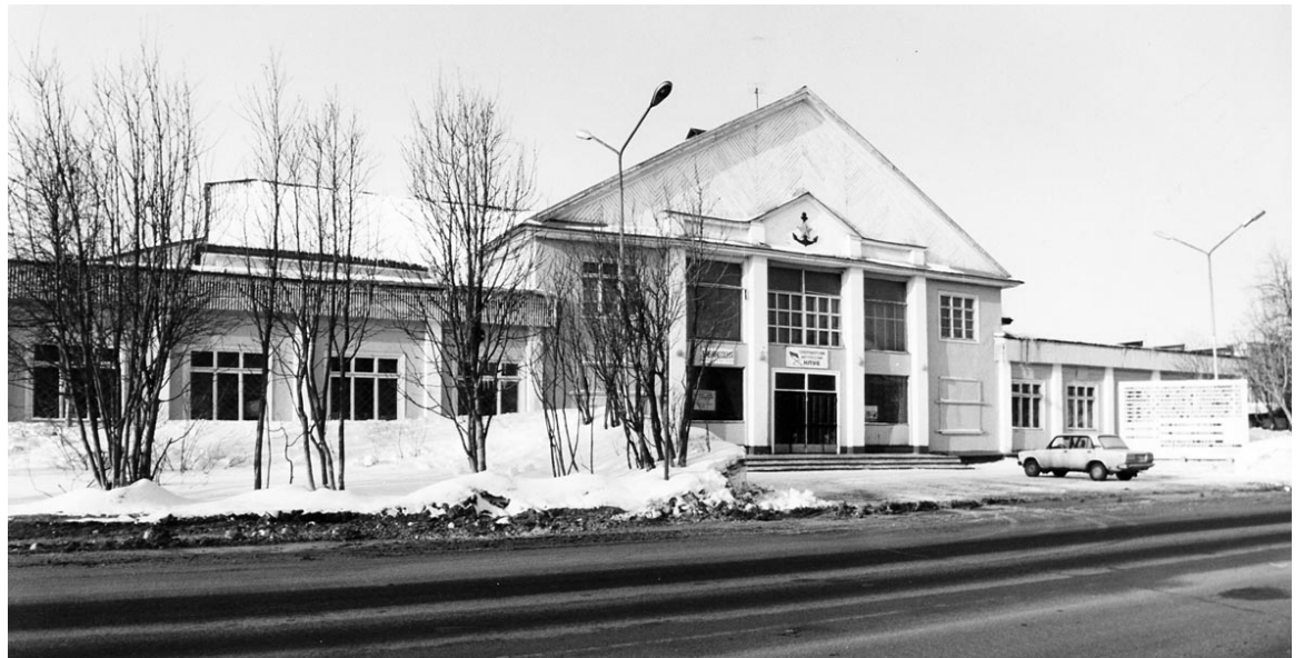
1994 год. После ремонта, проделанного силами сотрудников БМК, клуб стал выглядеть как новенький.
