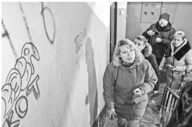
Алена Кузнецова, осматривает подъезды в микрорайонах ул. Фл. Строителей и Комсомольской, посоветовала УК расширить список из 40 подъездов, в которых запланирован косметический ремонт в 2023 году.
