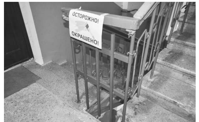
УК «Инвест ЖКХ» восстановила ограждение лестничных пролетов в первом подъезде дома №7 по ул. Сафонова.
