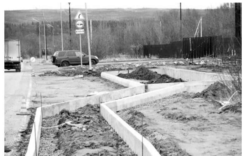
Поворот на Малое Сафоново. Заездной карман сформирован, впереди асфальтирование и монтаж остановки.
