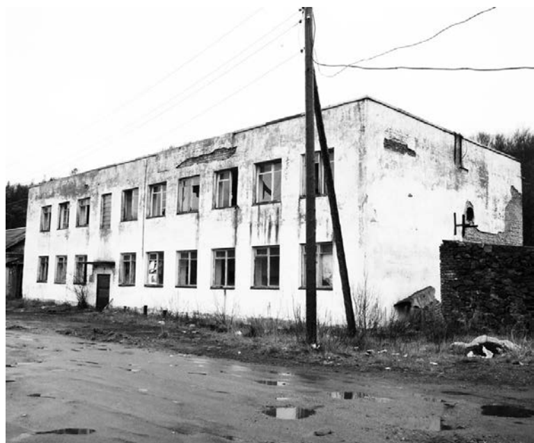
Пока здание приюта выглядит неприглядно, но через несколько месяцев оно должно полностью преобразиться.
