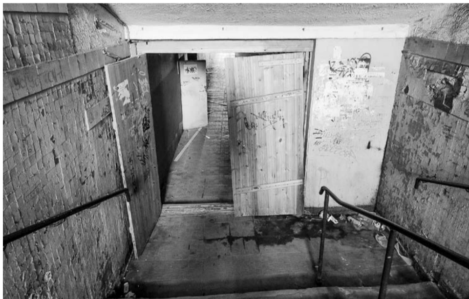
Прежде чем приступить к ремонту подземного перехода, необходимо провести большую подготовительную работу: обследовать внутреннюю часть, коммуникации, рассчитать транспортную нагрузку.
