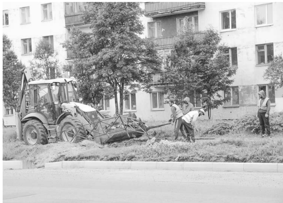
На улице Кирова дорожные рабочие готовят тротуар к визиту асфальтоукладчика.
