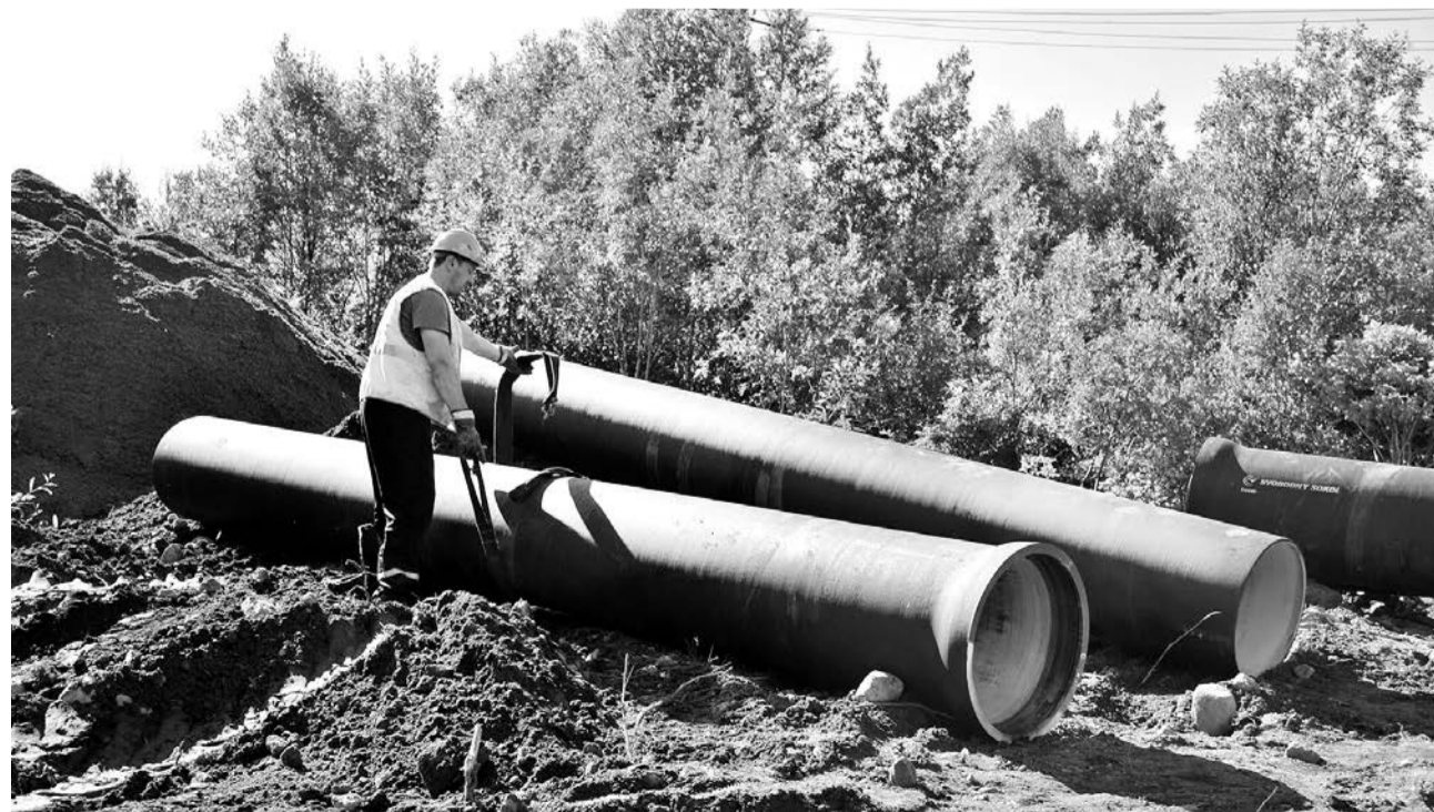
2017 год, укладка двухкилометрового магистрального трубопровода от сопки Маячной к станции первого подъема.
