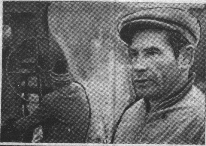
На строительстве Териберских ГЭС
