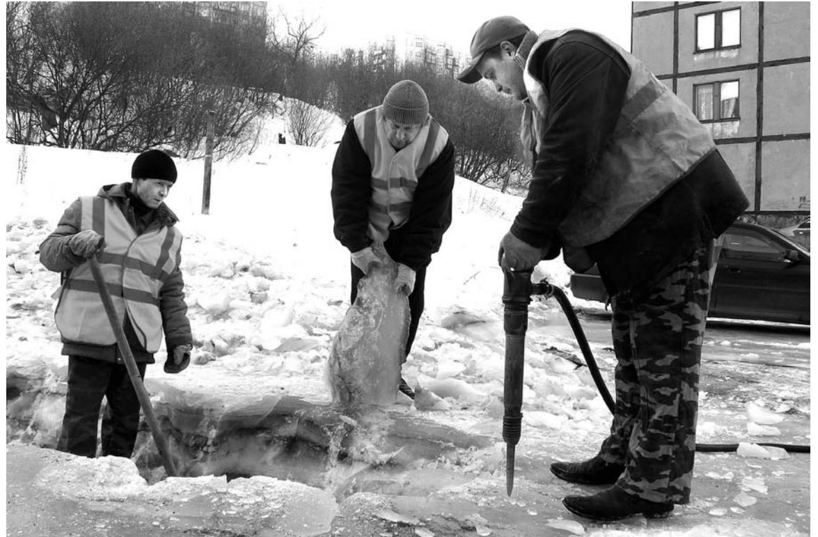
Отвод для воды прорубают рабочие по благоустройству ЖЭУ-3 Сергей Павленин, Алексей Камоликов и Михаил Цаплин.
