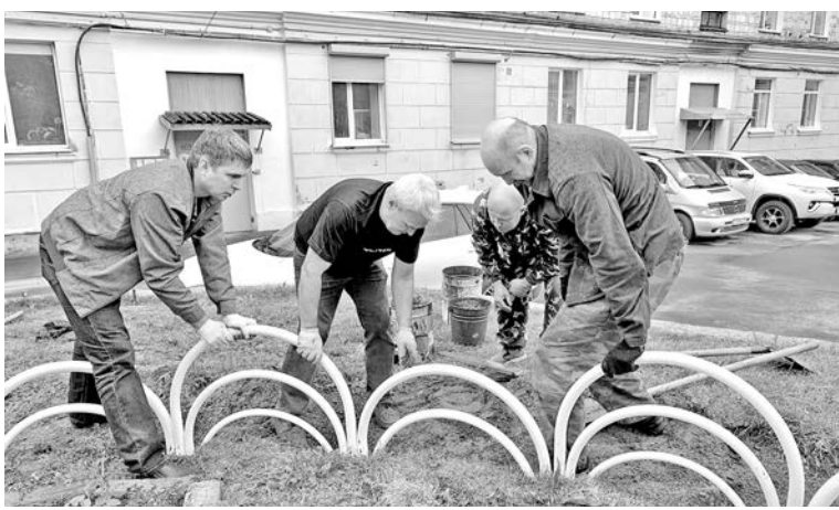
Мужчины, проживающие по ул. Душенова, 10, дружно устанавливают ограду палисадника.
