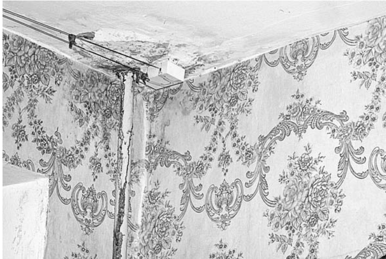
На снимке, сделанном через две недели после залива, ясно видны ржавые разводы от воды.
