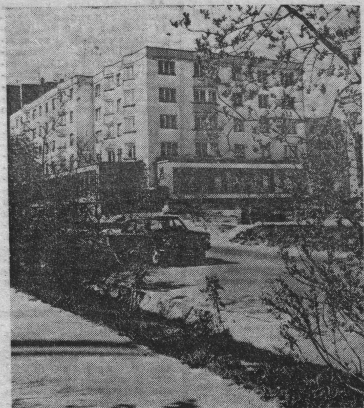
Североморск. На перекрестке улиц адмиралов Душенова и Голвока.
