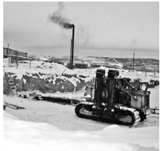
На первый взгляд, стройка на ул.Кирова замерла. На самом деле ведется подготовка к установке свай.
