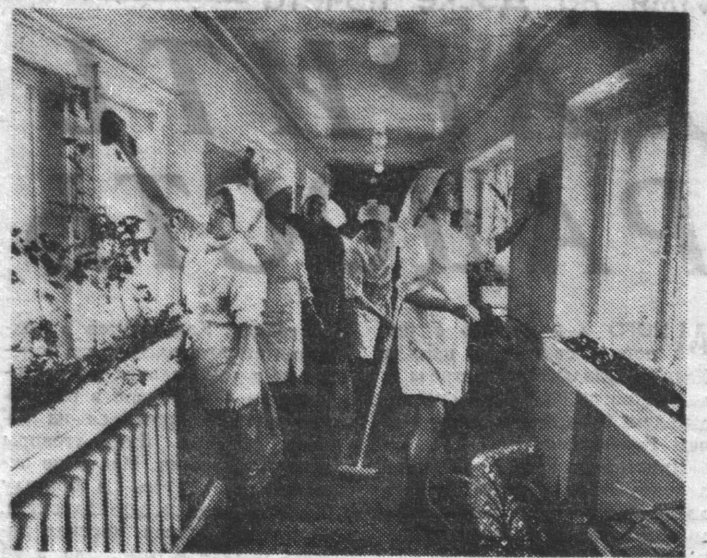
Переходная галерея, соединяющая административный корпус с главным зданием Североморского молокозавода, превращена в зеленую оранжерею. Работники предприятия заботливо ухаживают за цветами, высаженными здесь. Приятно пройти по галерее, когда за окнами бушует яростный снежный «заряд»... Много зелени и в кабинетах административного корпуса, и
