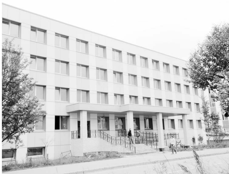
Бывший учебный корпус СВМС после реконструкции и облицовки украсил улицу Падорина.
