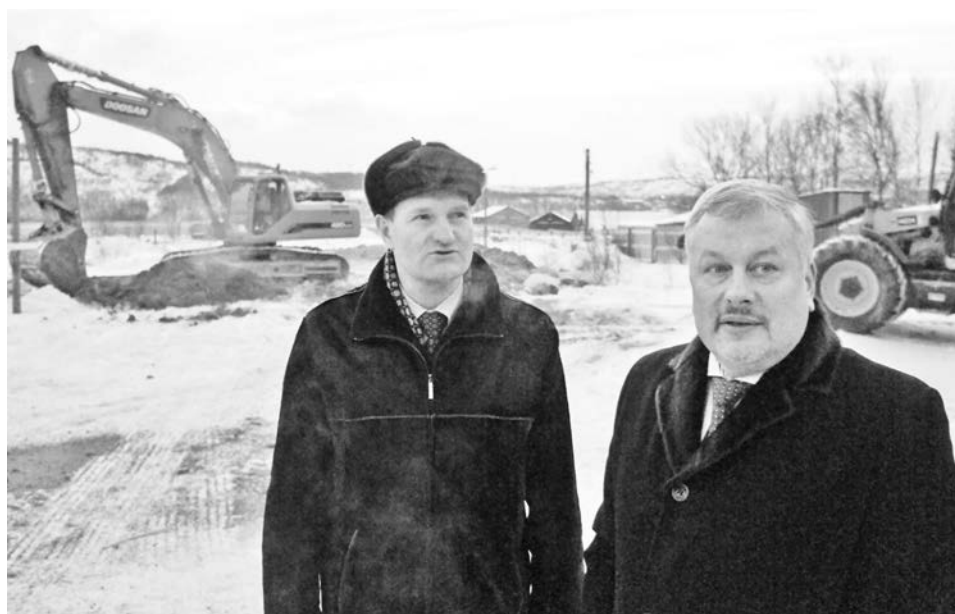
Глава ЗАТО Александр Абрамов (справа) и первый замглавы администрации Андрей Варзугин контролируют ход строительства.
