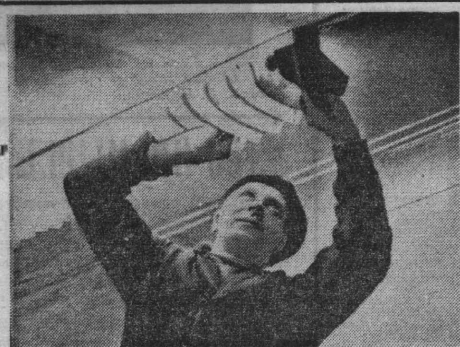
Со дня образования в городе Североморске ремонтно-строительного прорабского участка работает в нем электромонтажник пятого разряда коммунист Александр Иванович Беляков. Из года в год подтверждает он звание ударника коммунистического труда, с гордостью носит звание «Ударник 9-ой пятилетки». Высокочастотно работает коммунист и в десятой пятилетке. НА СНИМКЕ: А. И. Беляков устанавливает светильник в помещении отделения станции «Скорая помощь» в Североморске. Фото В. Матвейчука.
