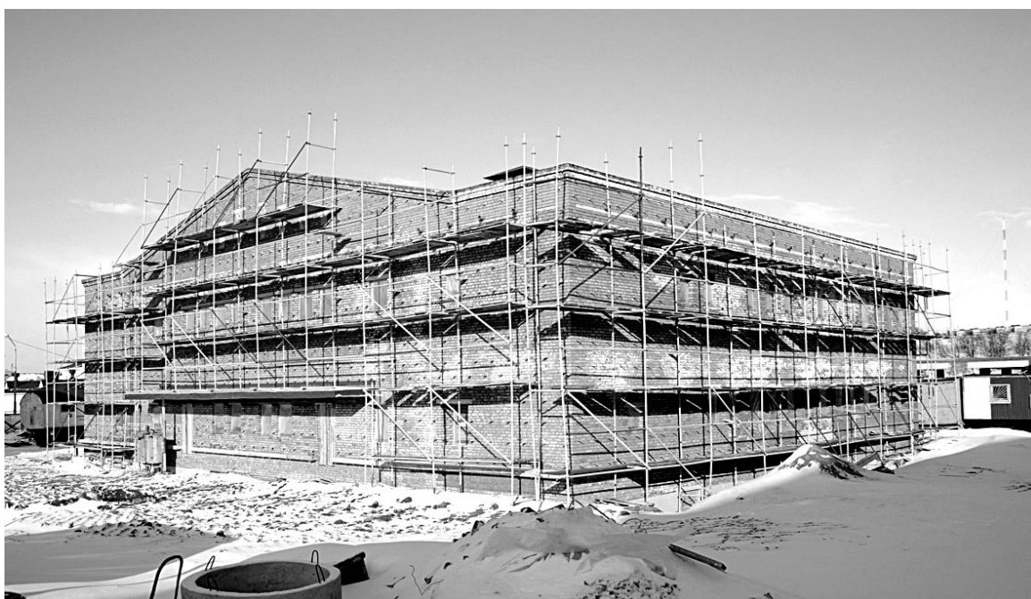
Сейчас городская баня на ул.Пионерской в строительных лесах - к зиме будет в мраморе.
