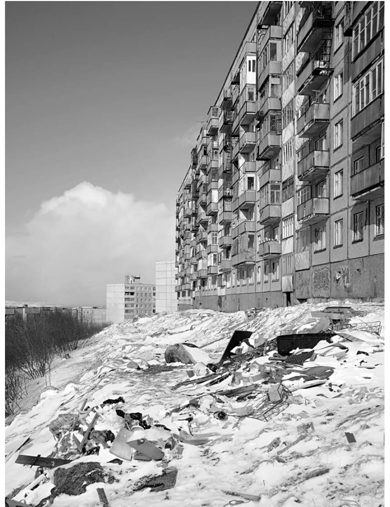
Склоны на улицах Полярной и Инженерной стараниями жителей превратились в свалки.
