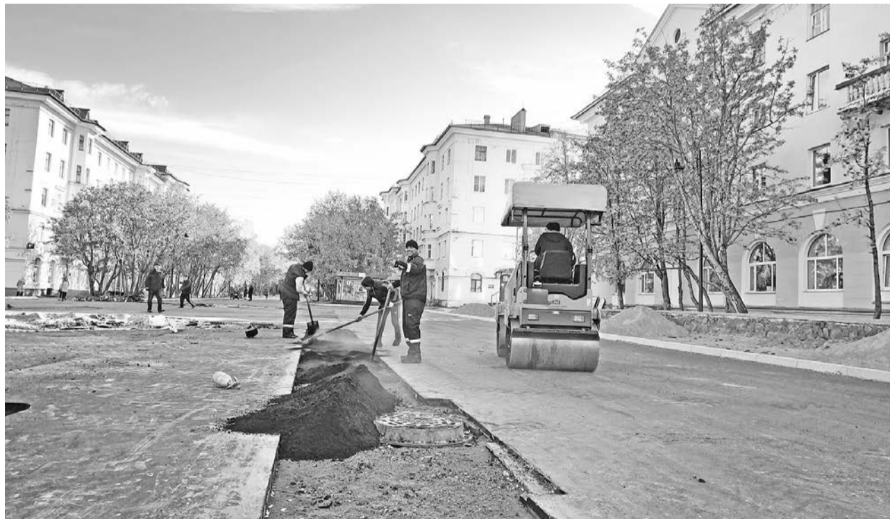
На ул.Сафонова рабочие вскоре приступят к укладке декоративной плитки, все материалы уже в наличии.
