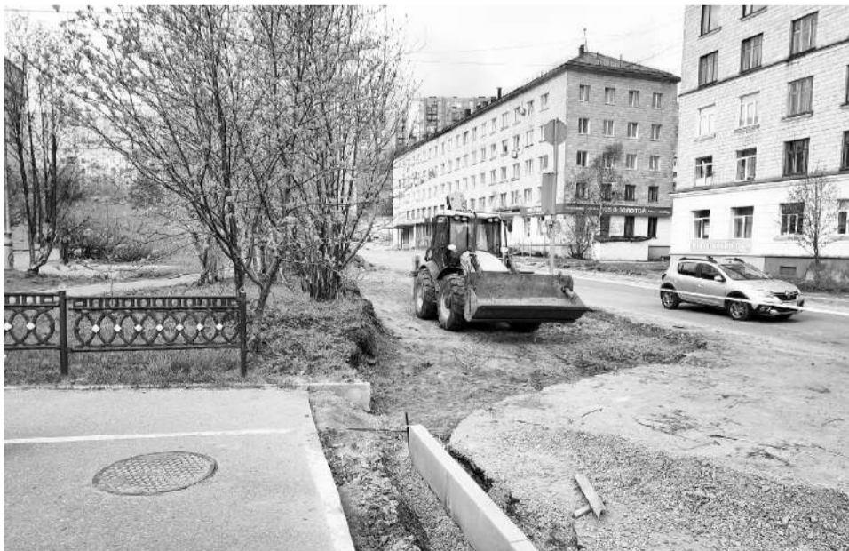
Работы по обустройству площадки для заездного кармана на ул. Ломоносова уже начались.
