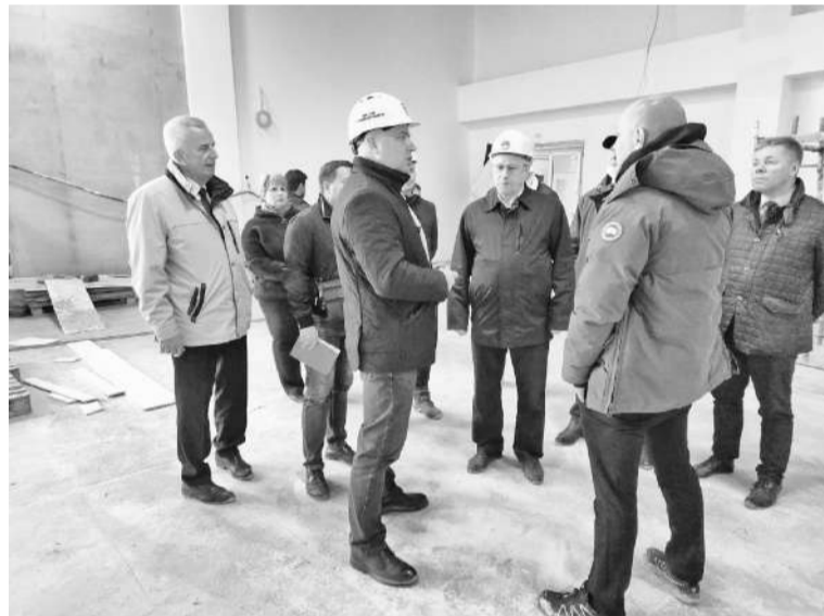
Владислав Сандурский: «Контроль стройки будет еженедельным».
