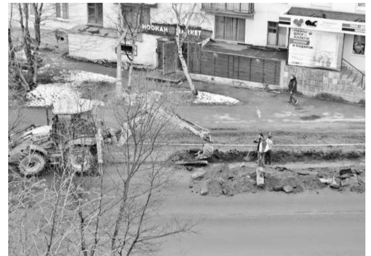
Ливневая канализация и новый бордюрный камень появятся на ул.Душенова.
