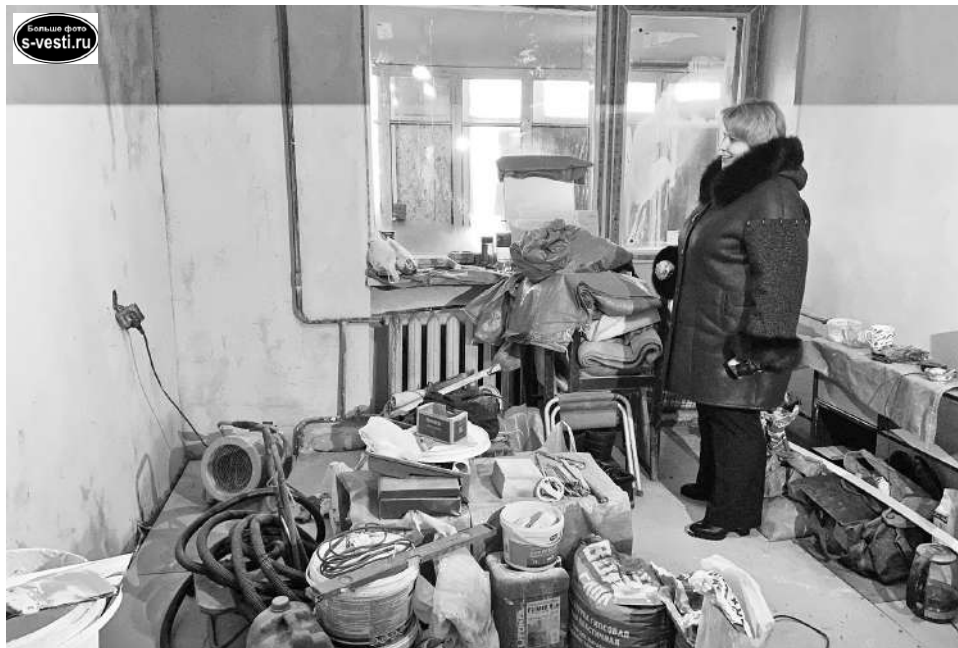
Евгения Гордеева проконтролировала ведение ремонтных работ.
