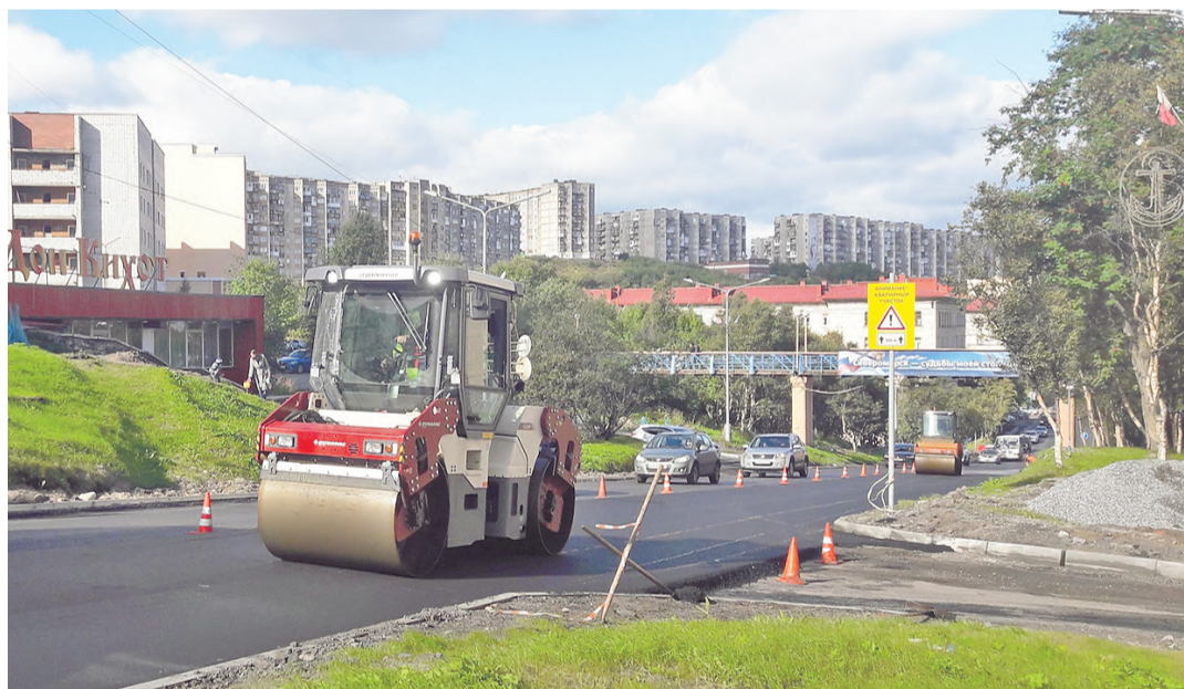
В рамках летней дорожной кампании в городе комплексно отремонтировали сразу нескольких больших проездов: на ул. Колышкина и на проезде Душенова - Адмирала Головки - Сивко. В 2021 году продолжение следует...
