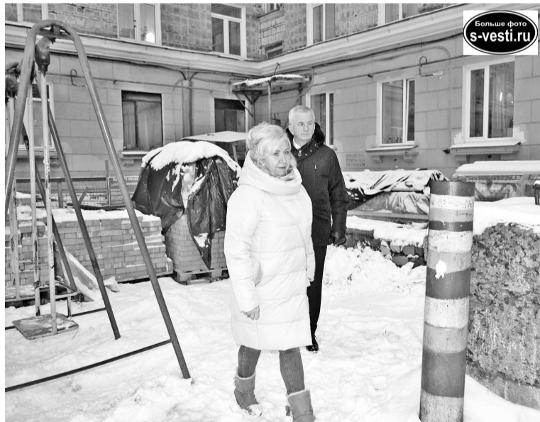
Елена Завадская и Евгений Алексеев взяли на контроль ситуацию со складированием стройматериалов на детской площадке по ул.Комсомольской, 3.
