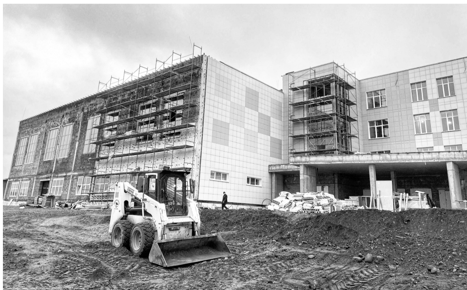
На трех из пяти корпусов уже уложены крыши, ведутся внутренние отделочные работы.
