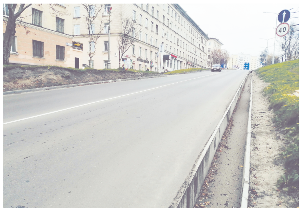
Реконструированная ливневка на ул. Душенова успешно прошла первые испытания дождями.
