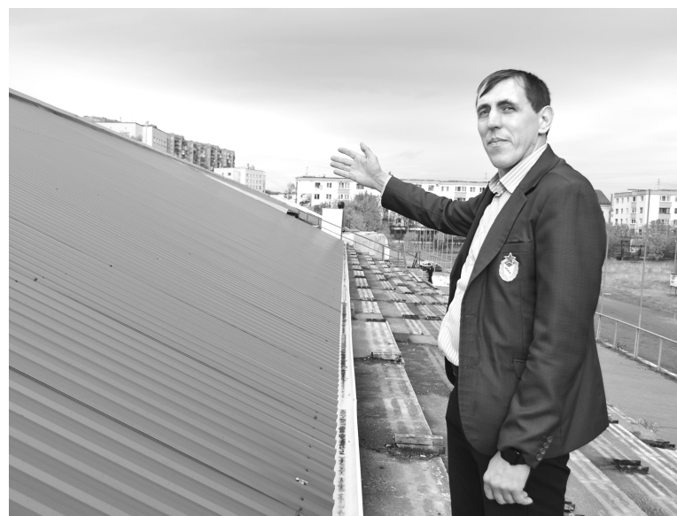
Игорь Дреманов: «Настил защитит трибуну от дальнейшего разрушения».
