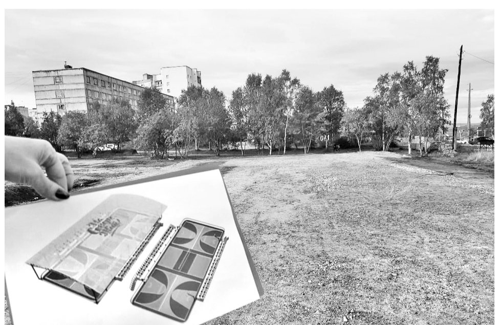
Нулевой цикл работ на месте будущего корта в Авиагородке завершен, территория полностью готова для монтажа многофункционального оборудования.
