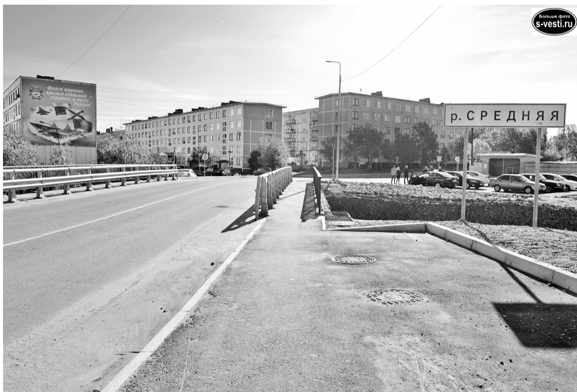
Поселок Североморск-3. Участок дороги от моста через реку Среднюю до детского сада недавно приведен в нормативное состояние.
