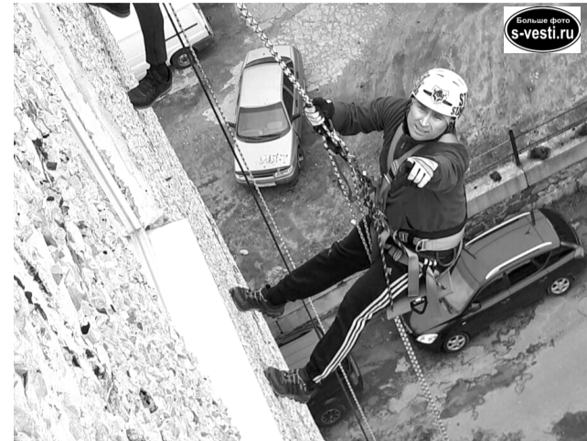
При подготовке жилого фонда к осенне-зимнему периоду было отремонтировано порядка 500 погонных метров межпанельных швов.
