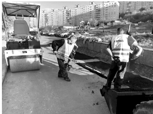
Ремонт дорожного покрытия на придомовых территориях - один из пунктов летней ремонтной кампании.
