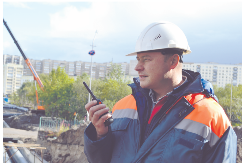
Сотрудники 46-й ТЦ теперь обслуживают самую современную в городе теплоцентраль.
