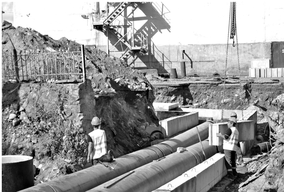
Специалисты ООО «Термоизолстрой» работают в соответствии с графиком.
