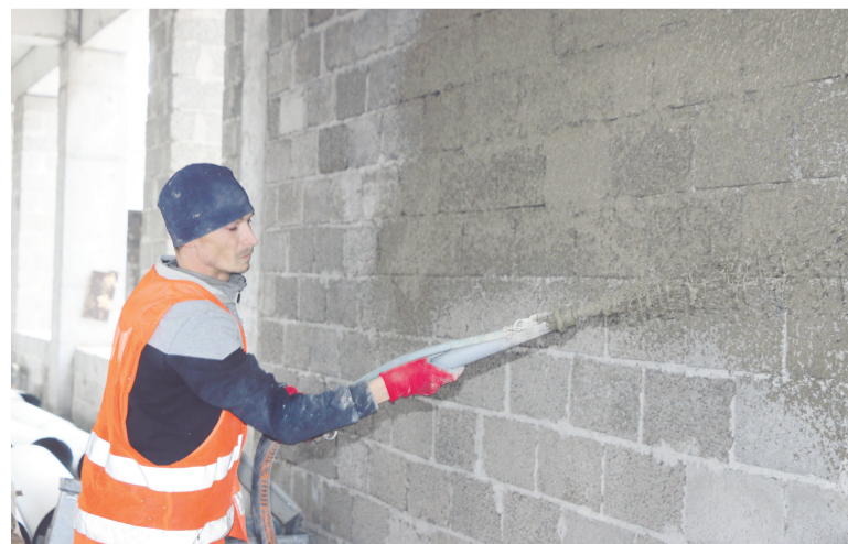
Строители продемонстрировали современную технологию нанесения на стены шпаклевки - с помощью шпаклевочной станции.
