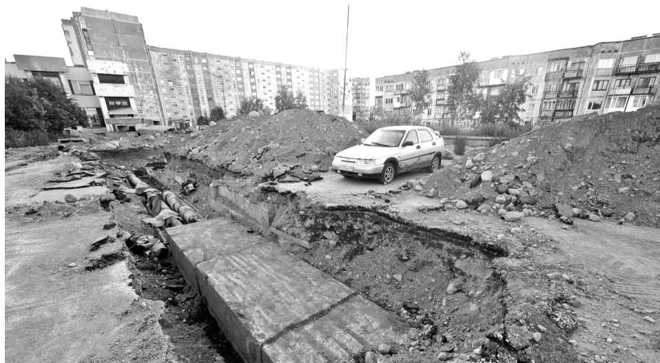
Ремонт трубопровода в районе ул.Адм. Сизова требует дополнительного отключения горячей воды с 16 по 23 июля в 19-ти МКД и трех социальных объектах.
