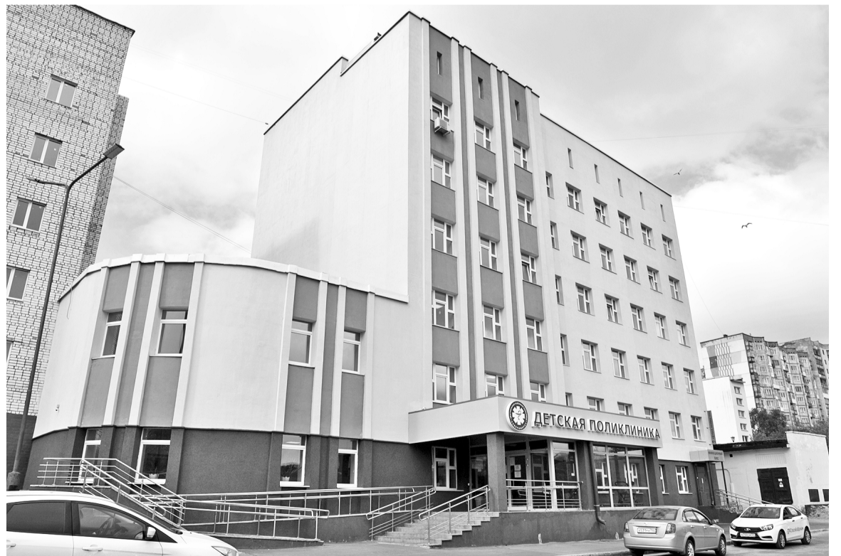
В отремонтированной детской поликлинике созданы все условия для комфортного пребывания маленьких пациентов и их родителей.
