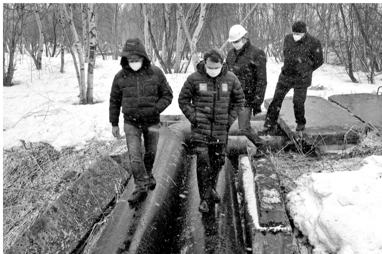
Областная комиссия во главе с Андреем Чибисом лично проверила состояние потенциально опасных участков теплотрассы.
