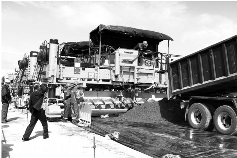
Перед укладкой бетона гости могли бросить в него монетку - на удачу.
