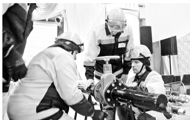
Монтаж хомута и задвижки - повседневная работа профи.
