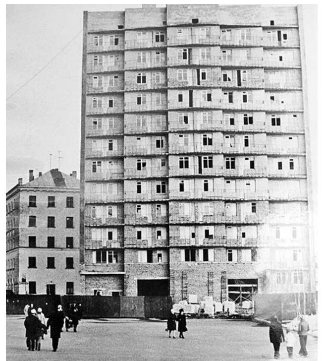
Строительство дома №26 на ул.Сафонова – первого 12-этажного здания во флотской столице.
