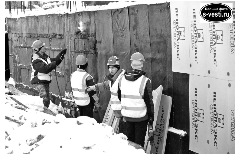
Рабочие уже начали утеплять фундамент будущей школы.
