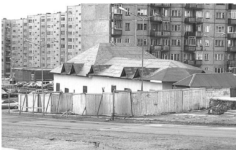
Четыре месяца спустя стройку не узнать: появились стены и крыша будущего павильона.
