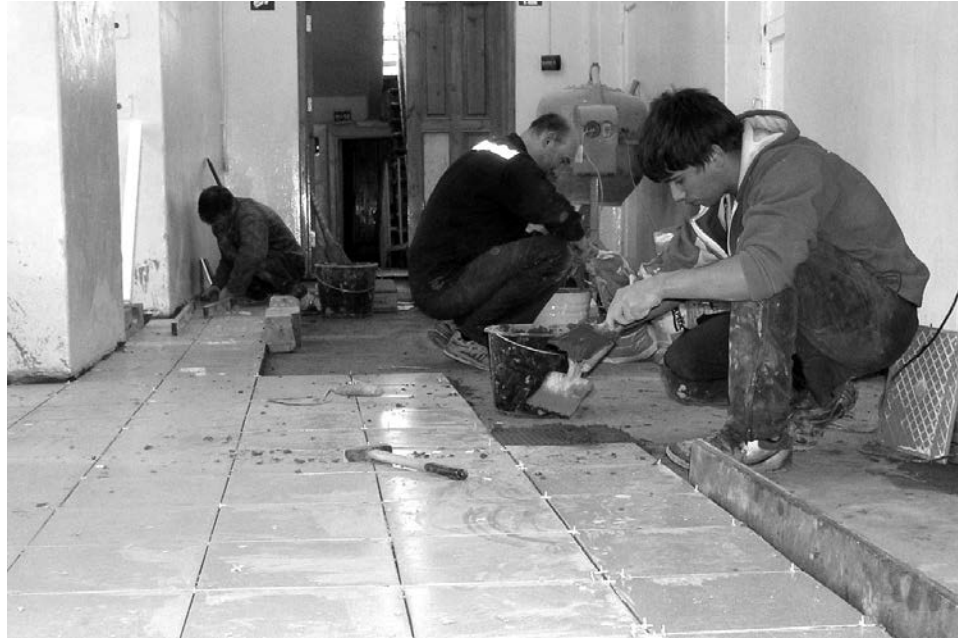
Среди рабочих, укладывающих пол в СШ №1, есть и школьники из трудовых бригад.
