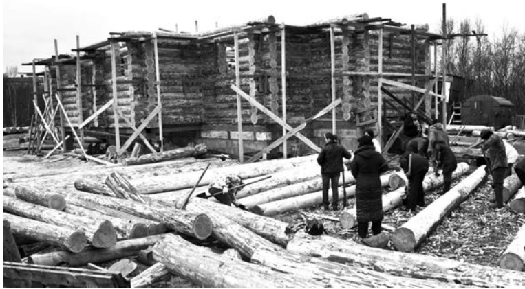
Процесс окорения бревен в мае.
